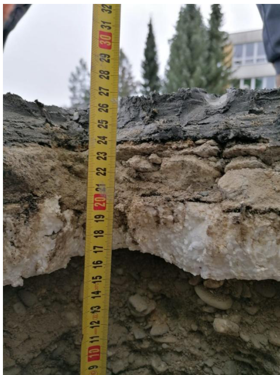
Obrázek 1: Fotografie sondy S1 do střešního pláště objektu kotelny – vrchní část skladby
